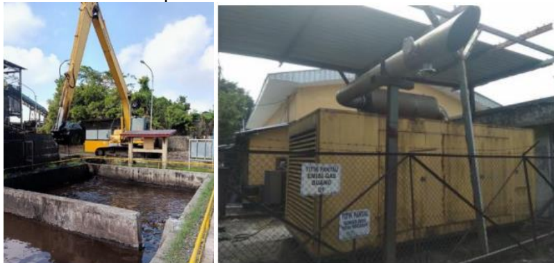
Gambar 6. Alat berat Excavator dan Genset di PT X
