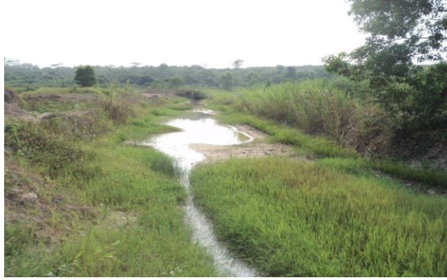
Gambar 4. Saluran Drainase Sumber: PT Adaro Indonesia, 2022
