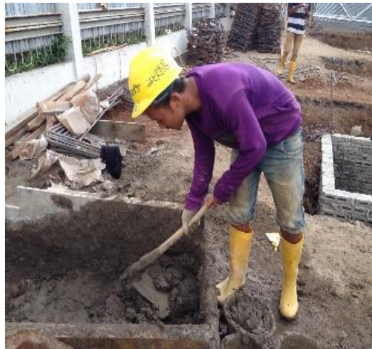
Gambar 3 Posisi Tenaga Terampil Saat Mengaduk Semen
