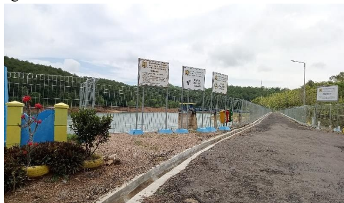
Gambar 4. Jalan Transportasi Bendungan Nawangan
