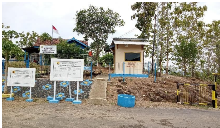
Gambar 3. Kantor pengelola Bendungan Nawangan
